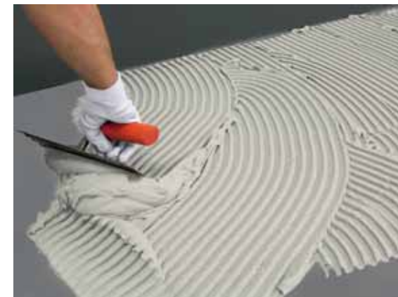
2- Aplicar el adhesivo con un doble encolado sin dejar huecos, primero en el reverso de la pieza con una llana de dientes planos de 3 mm y a continuación en el soporte con una llana de dientes inclinados de 6 mm, procurando cubrir también las esquinas y los bordes y evitar vacíos de aire entre el soporte y la pieza.
